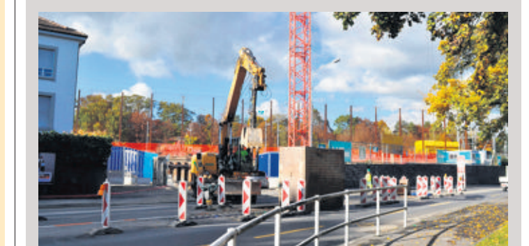
MORGES | HÔTEL DE POLICE Difficile de ne pas remarquer le chantier à l'avenue des Pâquis. Depuis le 9 mai, les travaux de construction du nouvel Hôtel de police suivent leur cours. Pour rappel, la PRM espère occuper ses nouveaux locaux pour les fêtes de fin d'année 2017. JDM
